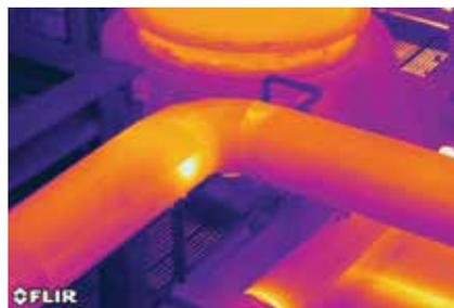
*Auf dem Wärmebild ist die fehlerhafte Isolierung einer Rohrleitung erkennbar. Dies kann den Produktionsprozess unterbrechen und eventuell gefährliche Unfälle zur Folge haben.*
