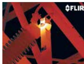
*Fehlerhaft befestigte Verbindung*
