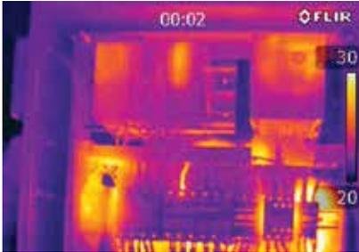
Wärmebildinspektion eines elektrischen Schaltschranks
