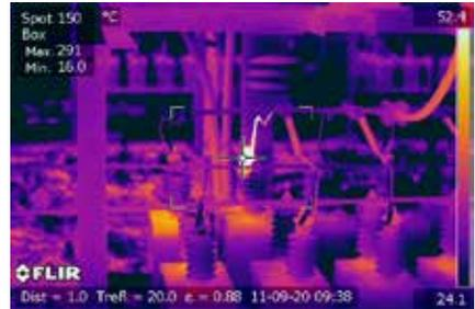
Auf diesem Wärmebild eines Hochspannungskondensators ist eine heiße Stelle zu erkennen, Hinweis für eine fehlerhafte Verbindung.
