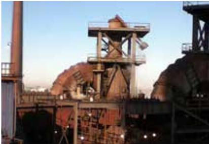
Jede Woche wird dieser Kessel mit einer Wärmebildkamera untersucht, um den Zustand der Feuerfestauskleidung zu überwachen.
