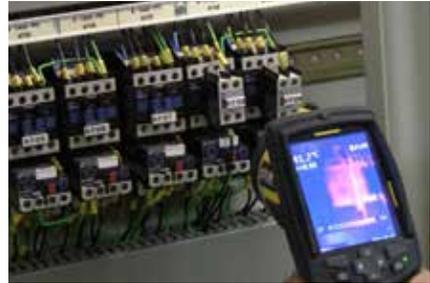
*Untersuchung einer Sicherung in einem elektrischen Schaltschrank*
