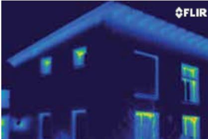
Das Wärmebild zeigt die Dämmungsqualität eines Niedrigenergiehauses.
