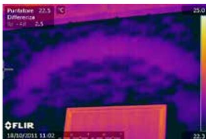
*Dieses Wärmebild zeigt, dass diese Wand zur besseren Gewichtsverteilung unter der Oberfläche Bögen enthält.*
