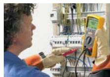
Isolationsprüfung an einer Unterverteilung
