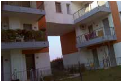
Tageslichtbild der Wärmeverluste am Gebäude
