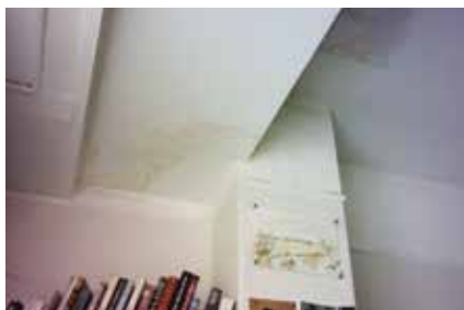
Hinter der Wand versteckte Warmwasserleitungen sind undicht. In diesem Fall ist der Wasserschaden anhand sichtbarer Zeichen erkennbar. Die Wärmebildkamera hilft bei der Lokalisierung der Position der Undichtigkeit.
