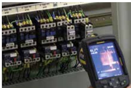
Untersuchung einer Sicherung in einem elektrischen Schaltschrank
